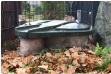
Das Anheben der Schachtabdeckung verhindert das Eindringen von Oberflächenwasser. links vorher, rechts nach dem Umbau.
