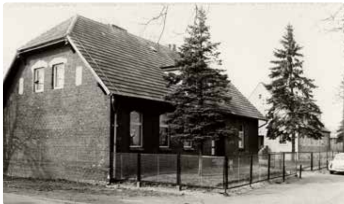
So sah das bereits als Kindertagesstätte genutzte Gebäude um 1990 aus. Seinerzeit war der alte rote Backstein noch gut zu sehen.
