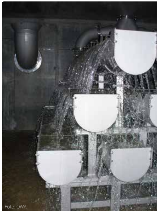
Rohwasserbelüftung im Wasserwerk Staaken
