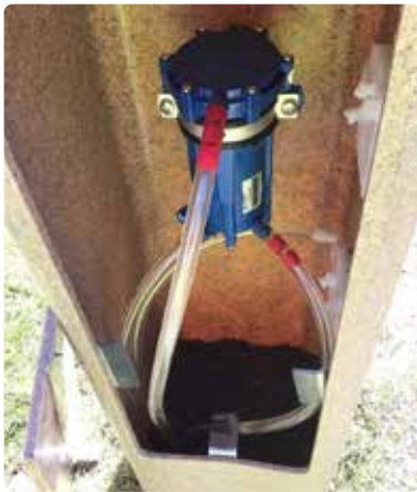
Auch die höhergelegten Steuergeräte tragen zur Betriebssicherheit bei. An einigen Stellen sind diese in Säulen außerhalb der Schächte untergebracht.
