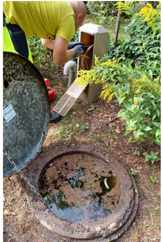
Durch den Umbau besonders gefährdeter Schmutzwasserschächte soll die Gefahr eines Ausfalls im Falle einer Überflutung der Anlage minimiert werden.
