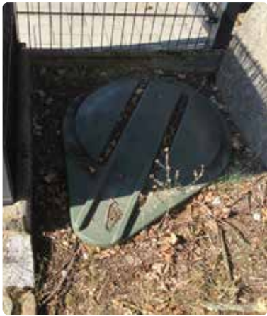
Das Anheben der Schachtabdeckung verhindert das Eindringen von Oberflächenwasser. links vorher, rechts nach dem Umbau.
