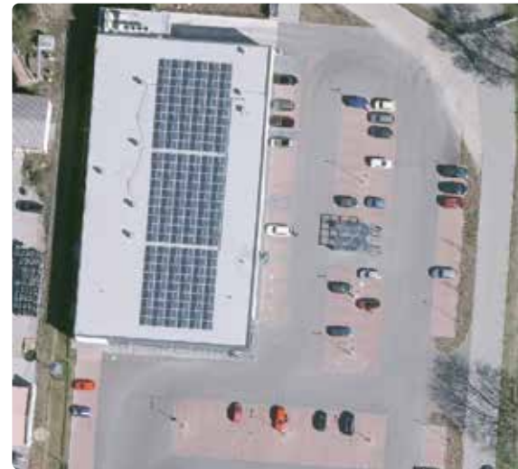
Beim Neubau des Lidl-Marktes wurde 2019 das Dach mit einer Photovoltaikanlage ausgestattet. Foto: Gemeindeverwaltung
