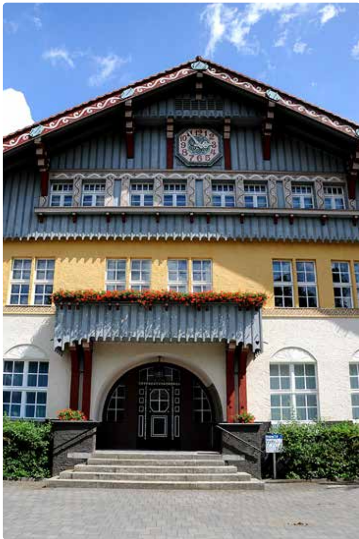
Das Verwaltungsgebäude ist reich verziert und besitzt eine Uhr
