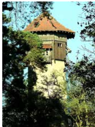
Marode, aber denkmalgeschützt: der alte Wasserturm
