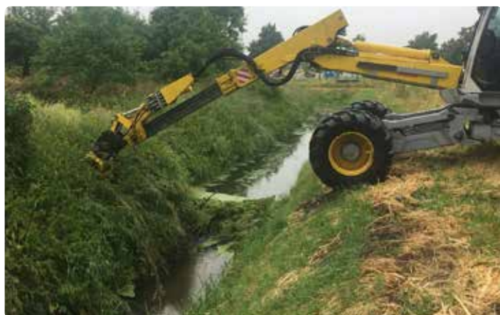
Biberdamm in Velten, kurz vor der Räumung im Rahmen der Gefahrenabwehr. Das Spezialfahrzeug stellte die vorderen Räder in den Graben und beseitigte in Kürze das Hindernis. In Strömen floss das gestaute Wasser in Richtung Veltener Kanal ab.
